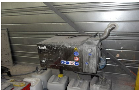
Photo 2 Nettoyage de spatules dans une machine de nettoyage des pistolets, équipée d'une aspiration
